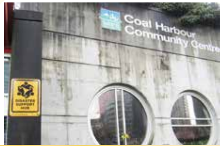
協議会のあと、バンクーバーの指定避難場所の1つを視察。このような黄色いマークが付けられている。ここにはある程度の食料や医薬品が備蓄もある
